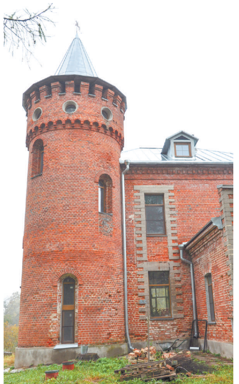
Над башней появилась кровля, дом постепенно ремонтируется
